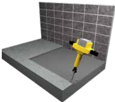
Entfernen Sie nun die eingezeichnete Fläche mit geeignetem Werkzeug (Meißel und Hammer bzw. Presslufthammer). Die entfernte Betonschicht sollte der gleichen Dicke, wie die des zu installierenden Duschelements, entsprechen. Schleifen Sie die Fläche anschließend gründlich ab.
